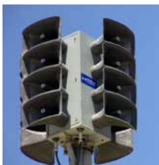
Figura 9: Sirene eletrônica direcional
