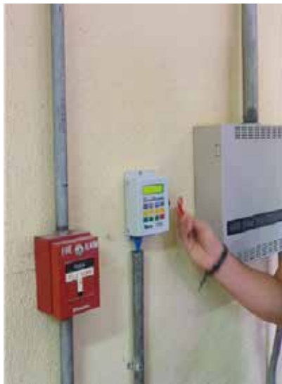
Figura 15: Dispositivo com chave magnética (cadastrada por usuário) para acionamento do sistema de alerta sonoro
